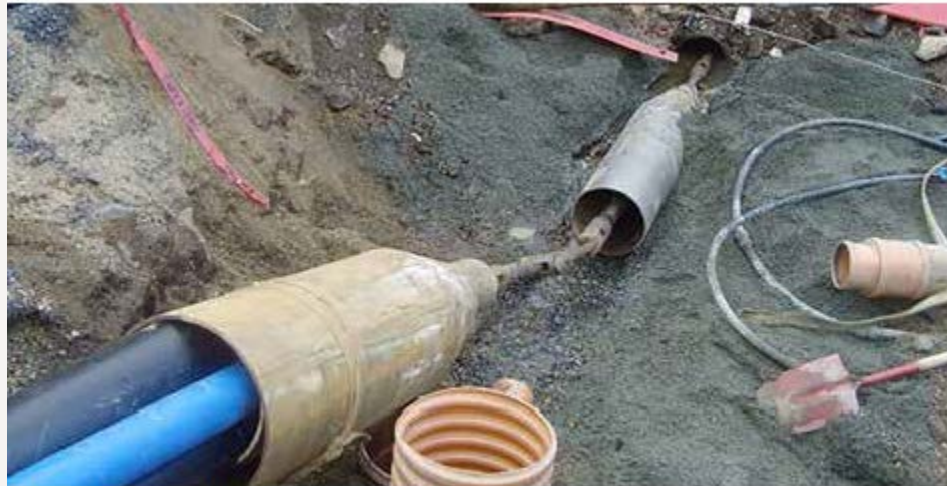
Utblokking med installasjon av tre nye rør i eksisterende rørtrasé.
